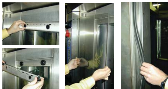
Remplacement des joints de porte
