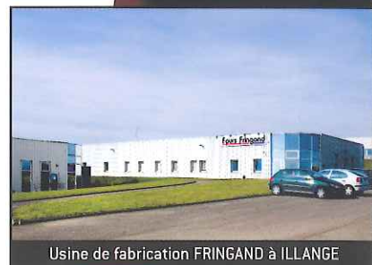
Usine de fabrication FRINGAND à ILLANGE
