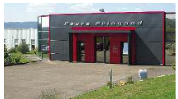
Usine de fabrication FRINGAND à ILLANGE
